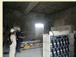
二人対面した部屋。現在は電池室
